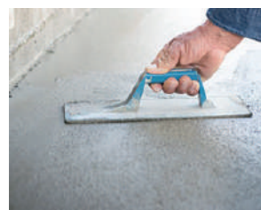
石膏とモルタルの修復
